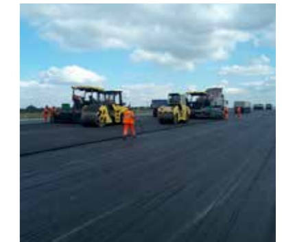
Radovi na modernizaciji i proširenju aerodroma
