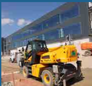
Radovi na modernizaciji i proširenju aerodroma
